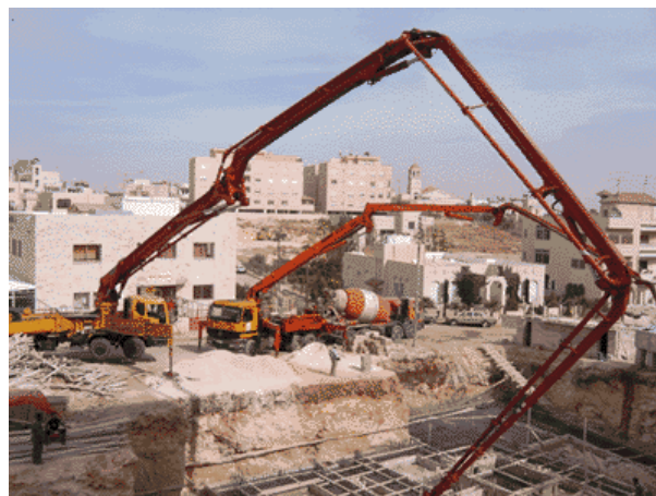
Рисунок 3.19 - Подача бетону в блоки бетонування
