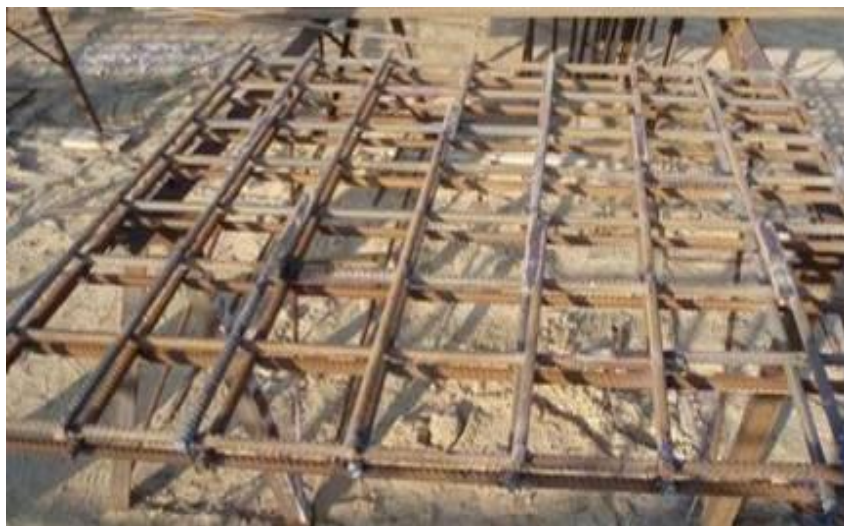
Рисунок 3.14 – Арматурна конструкція
